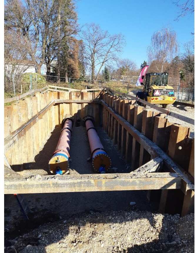
Battage de palplanches
