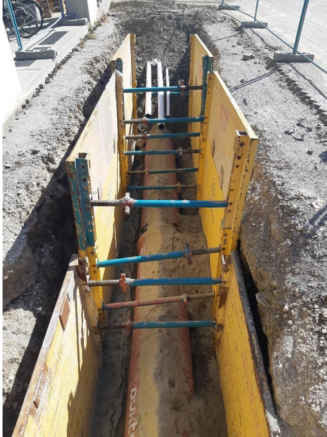
Caisson métallique type Krings
